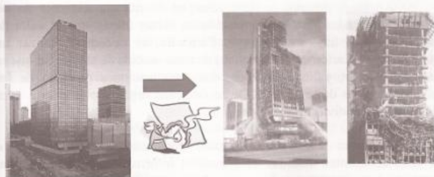
Figura 63. Incendio de la Torre Windsor en Madrid (12 febrero 2005)
